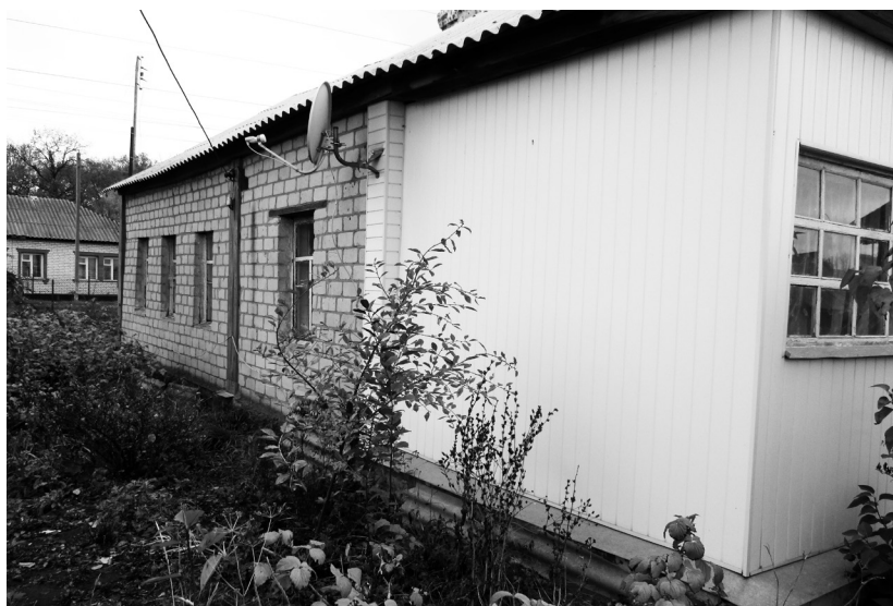
Дом А. Кузнецова. Анна, ул. Гоголя, дом 15. 2014 г.
